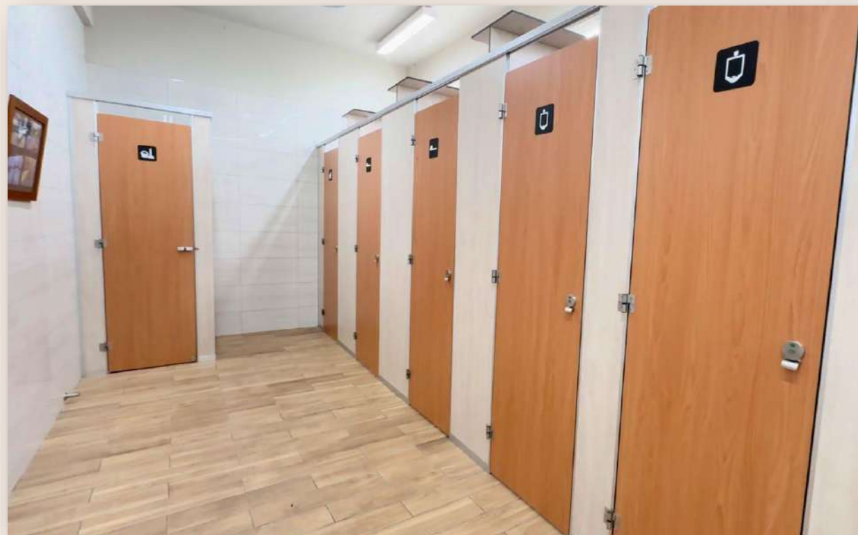
桃園市大安國小第二棟大樓性別友善廁所
