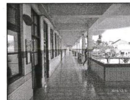
⑤ 現況照片- 走廊
