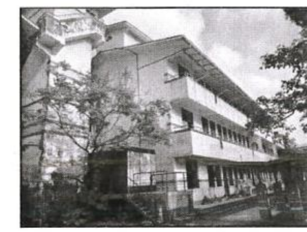
⑤ 現況照片-西向立面
