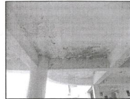
③ 現況照片- 走廊天花板
