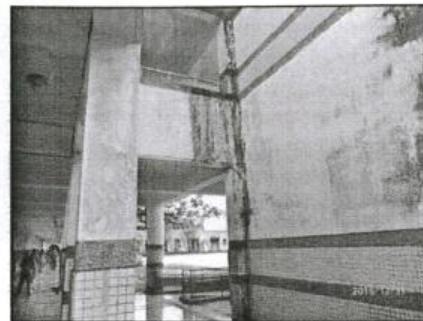
② 現況照片- 外牆角隅
