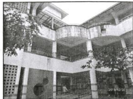
① 現況照片- 外牆轉角
