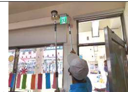
說明：測試逃生警示燈是否能正常運作。
