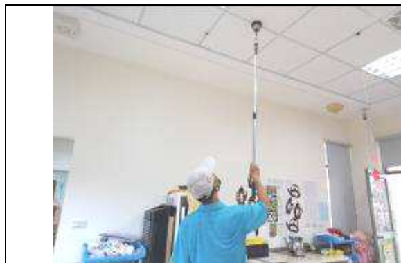
說明：檢視感應式煙霧自動警報系統。
