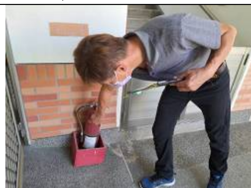
說明：檢視滅火器是否在有效期限內。
