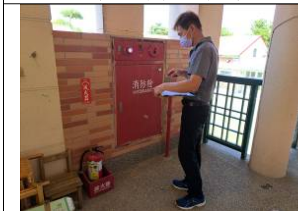
說明：檢視消防栓是否能正常運用。
