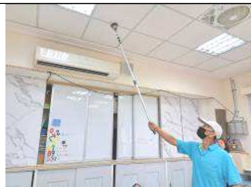
說明：檢視熱感應自動警報系統。
