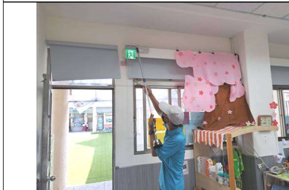
說明：測試逃生警示燈是否能正常運作。
