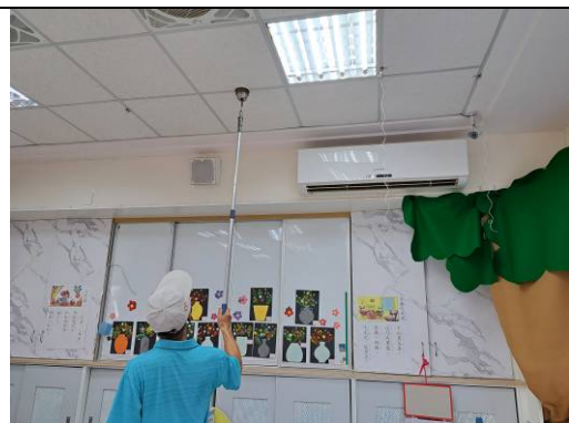
說明：檢視感應式煙霧自動警報系統。
