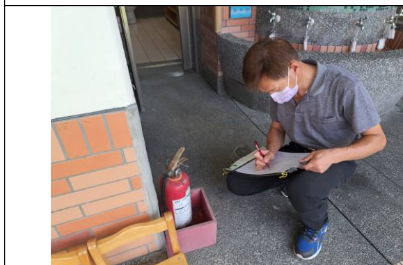
說明：檢視滅火器是否在有效期限內。
