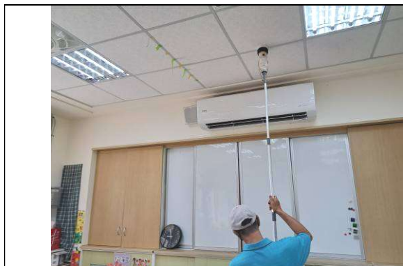
說明：檢視熱感應自動警報系統。
