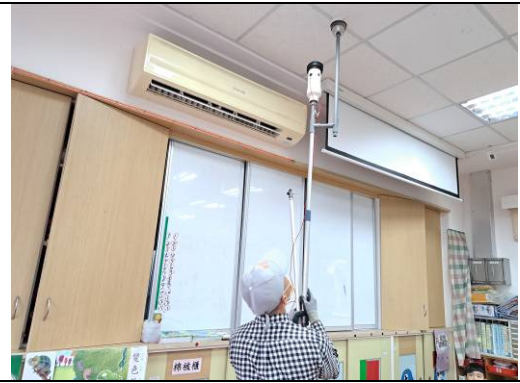
說明：檢視感應式煙霧自動警報系統。
