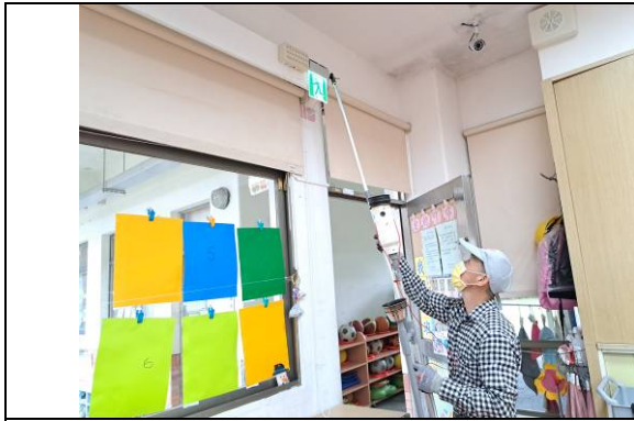
說明：檢視熱感應自動警報系統。
