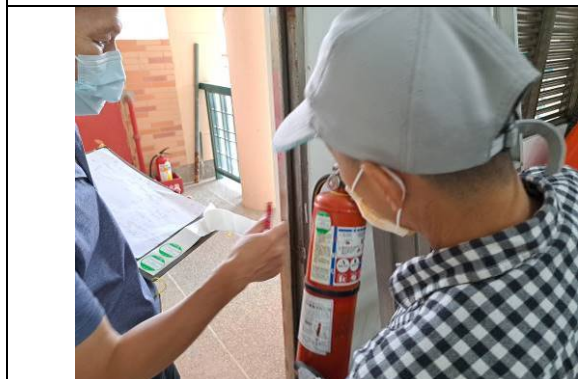
說明：檢視滅火器是否在有效期限內
