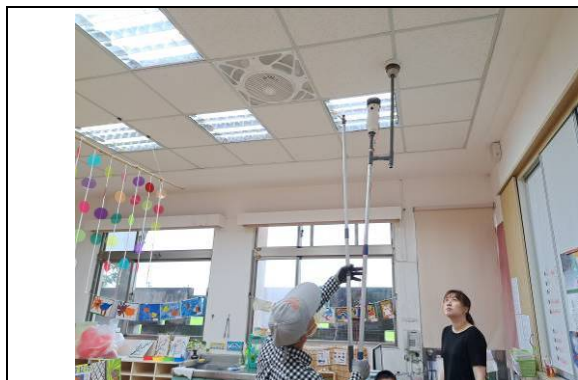
說明：檢視熱感應自動警報系統。
