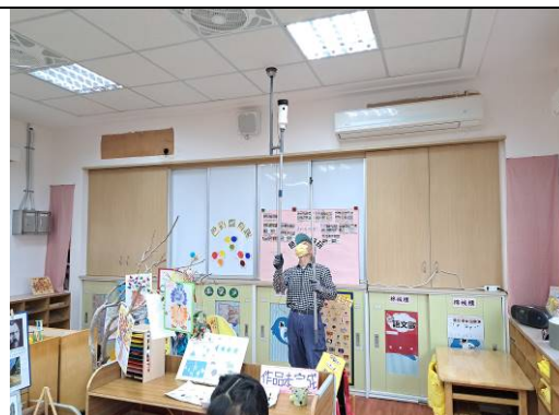
說明：檢視感應式煙霧自動警報系統。
