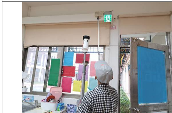
說明：檢視熱感應自動警報系統。
