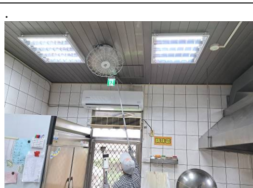
說明：檢視感應式煙霧自動警報系統。
