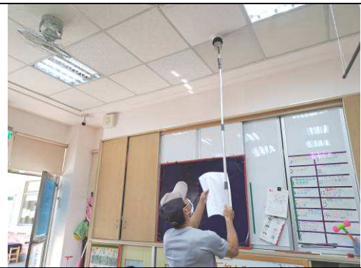
說明：檢視感應式煙霧自動警報系統。
