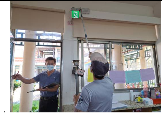
說明：檢視感應式煙霧自動警報系統。
