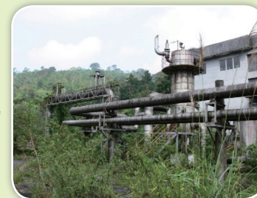
廢棄的地熱發電廠 ▶
