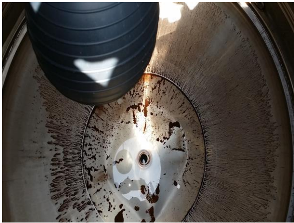
西側上水塔清洗前
