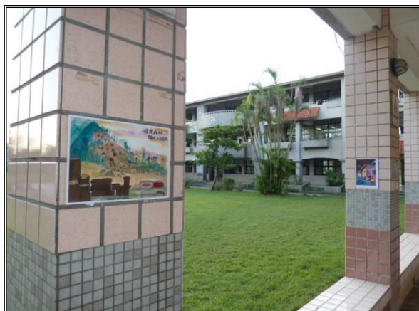
活動照片 1 (行政大樓走廊-1)
