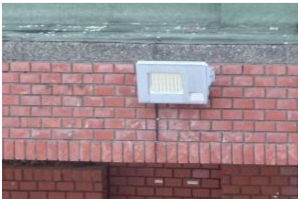
以感應式燈光搭配監視系統（全校監視系統）
