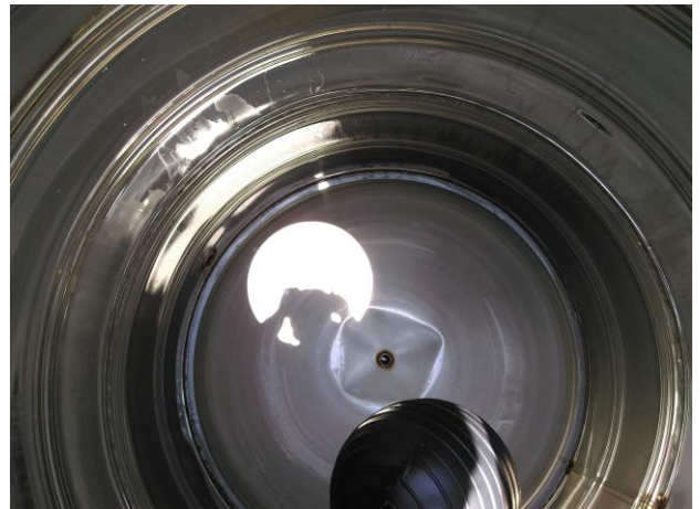
西側上水塔清洗後
