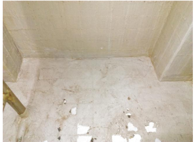
東側上水塔清洗後
