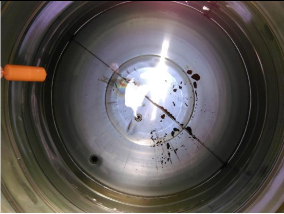
北側水塔清洗前
