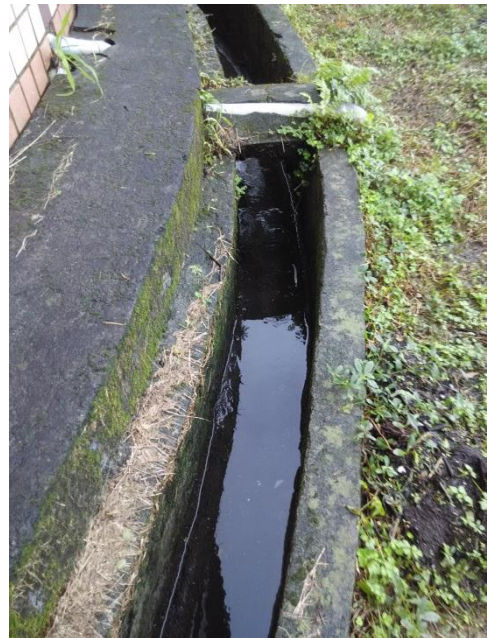
水溝定期清理雜草及除淤 (2)
