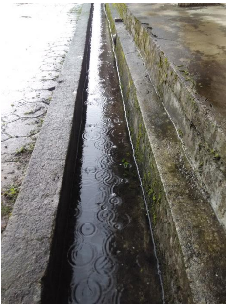
水溝定期清理雜草及除淤 (1)
