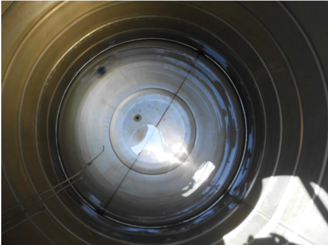
南側上水塔清洗前
