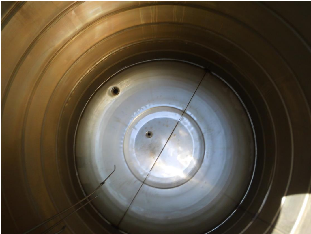
南側上水塔清洗後
