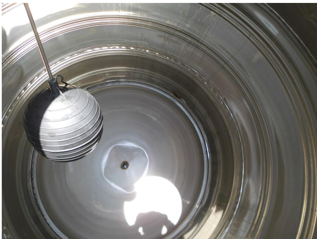
西側上水塔清洗後
