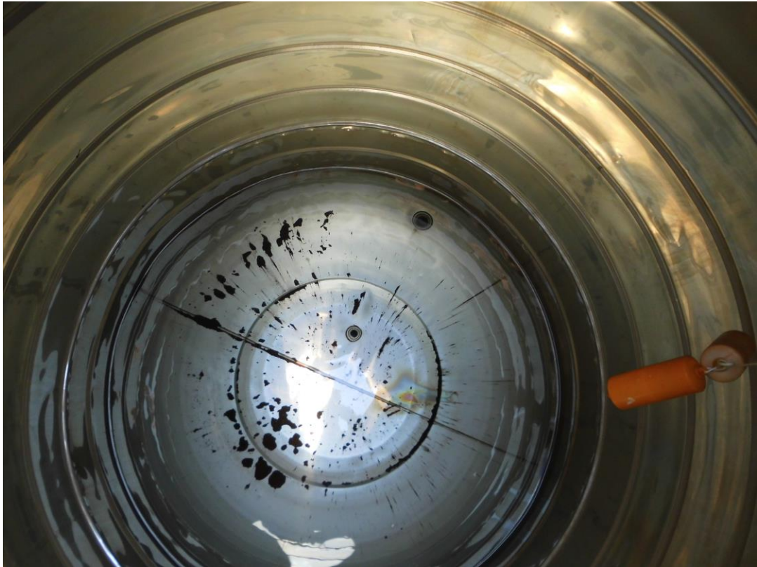
北側水塔清洗前
