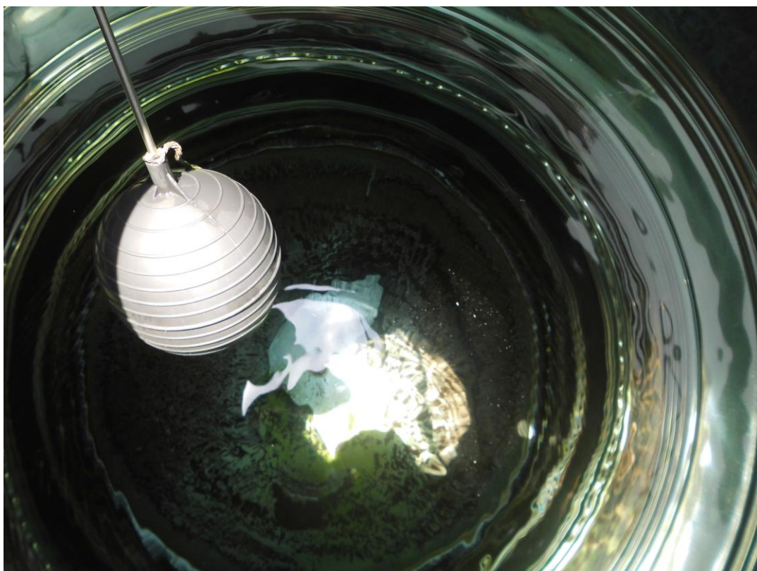
西側上水塔清洗前
