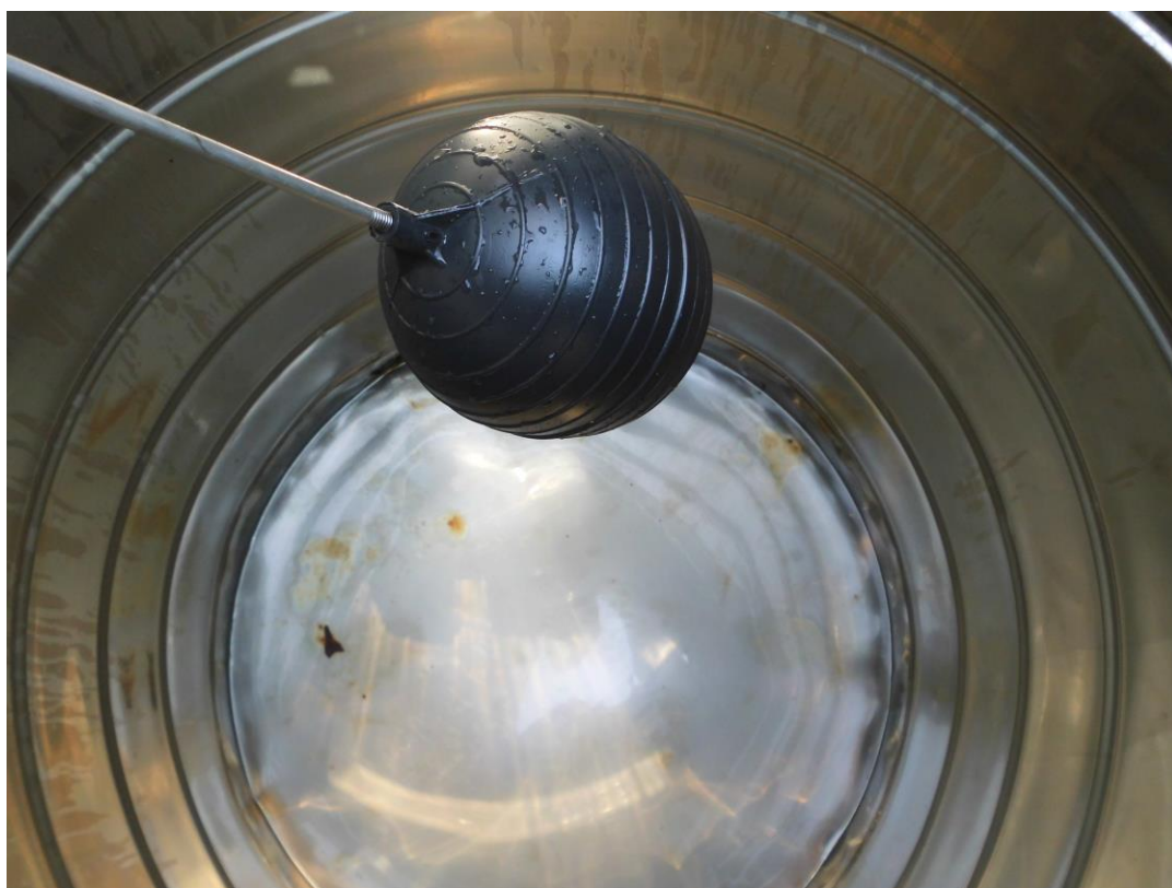
音樂教室上水塔清洗後
