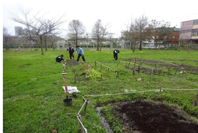
陸續整地完成及設置圍籬 (2016. 03. 14)
