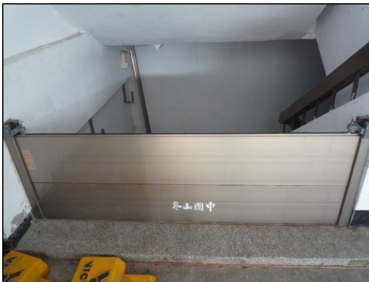
圖 16、設置防水閘門
