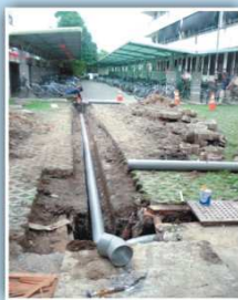
改善地下排水接管施工情形
