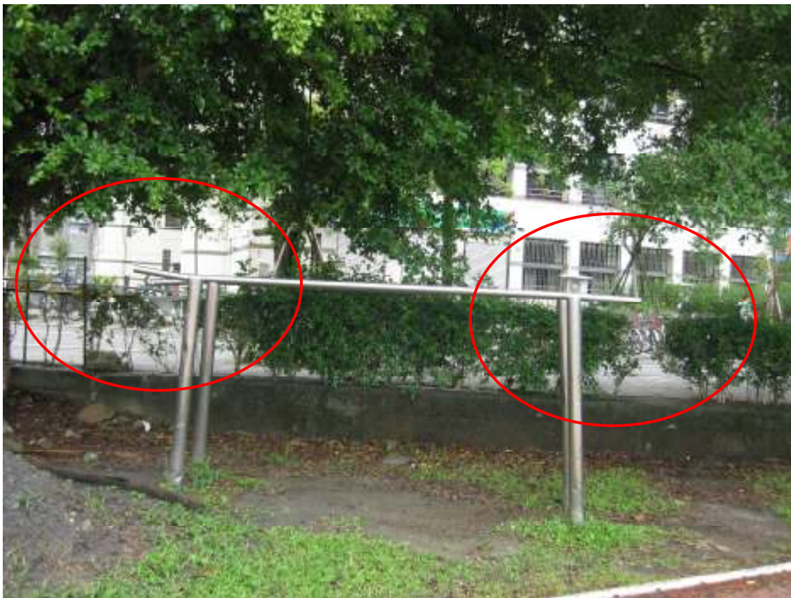
現況四、校後門農權路部份路段綠圍籬破壞且產生多處缺口
