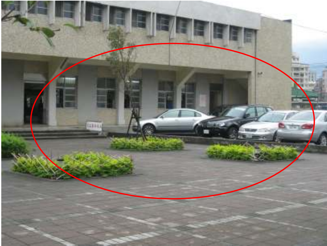
現況一、櫻花廣場—多處已遭病蟲害侵襲及颱風吹毀，存活率極低且無法恢復原始綠意
