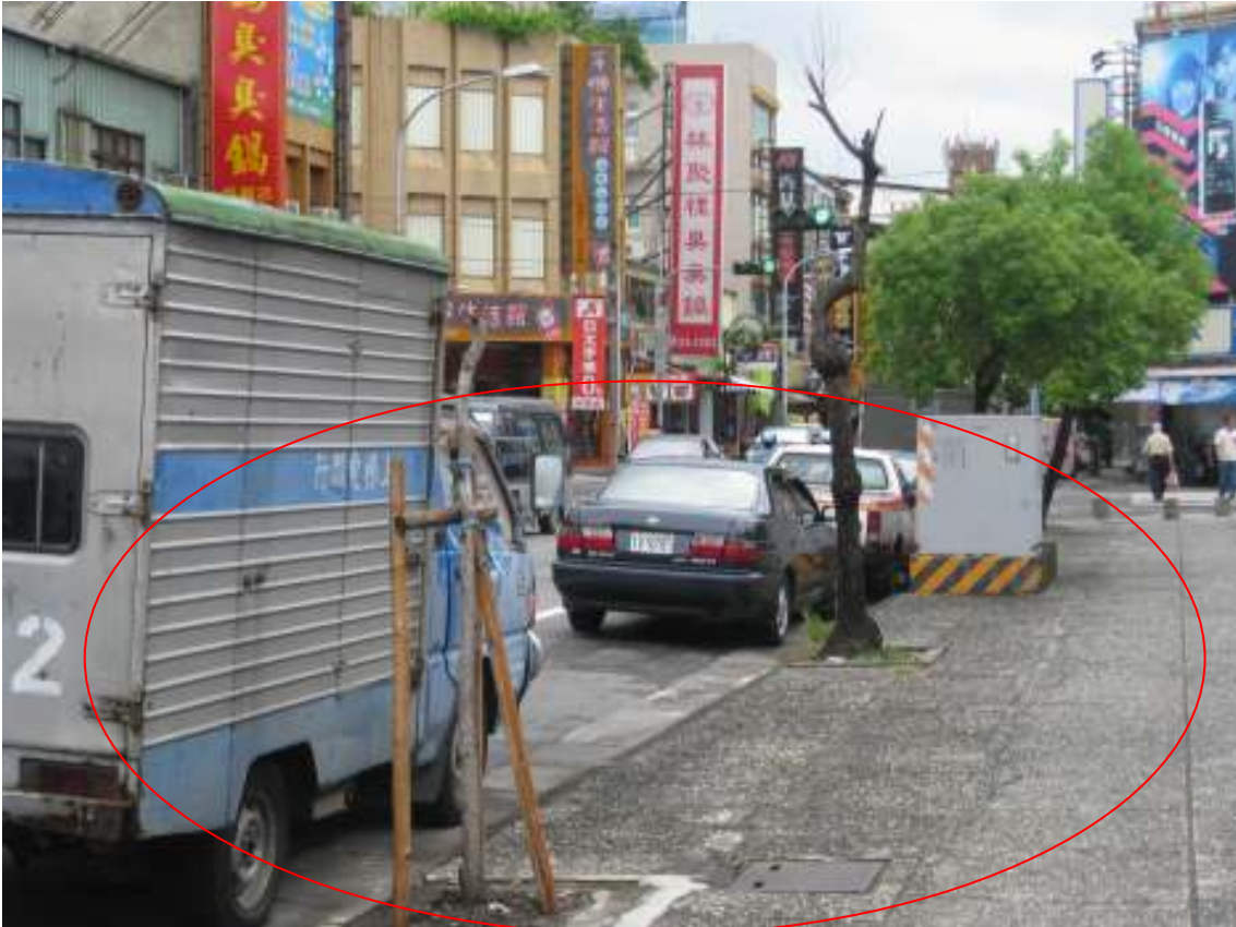
現況二、校門東側人行道樹計有八棵，多已呈現歪斜且有二棵已枯死，嚴重影響人行道美觀及校貌景觀
