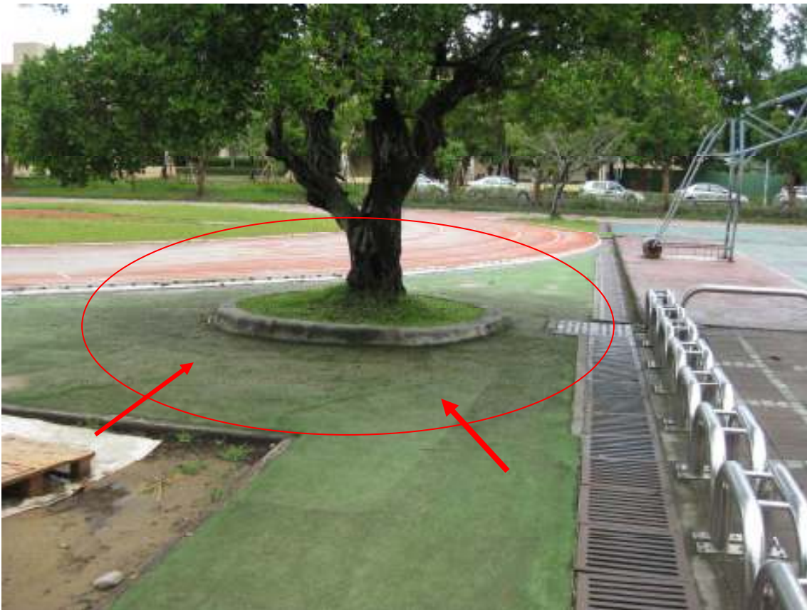
現況三、樹種根莖抓地甚深且已延伸至田徑場跑道，已造成部份地面隆起
