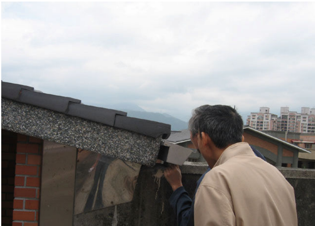
德馨樓水循環利用集水設施照片
