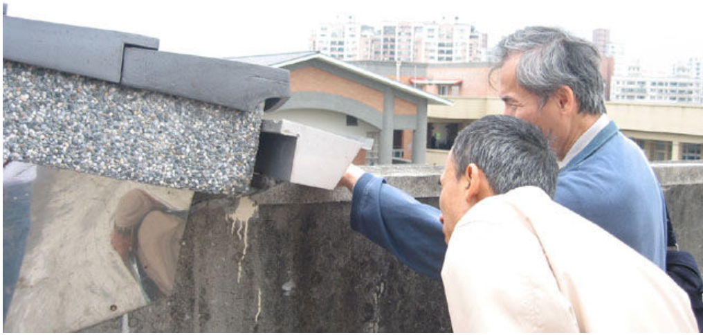
德馨樓水循環利用集水設施照片
