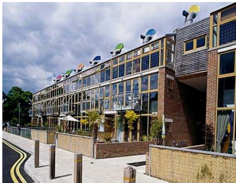
**亮點一：**建築頂部擁有眾多隨風靈活轉動的五彩“風帽”利用溫壓和風壓將新鮮空氣源源不斷送入建築內部，並將室內空氣排出。同時可利用太陽能 and “江水源”系統對進入室內的空氣進行除濕和降溫。
