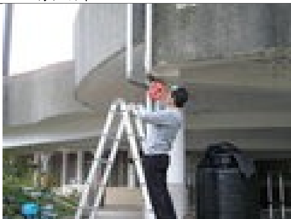
水循環系統施工中。
