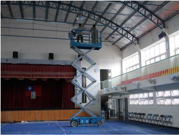
針對禮堂照明設備進行節能燈具更換
