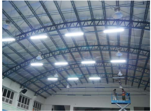
針對禮堂照明設備進行節能燈具更換
