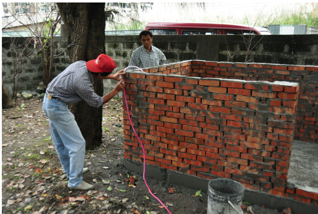
水泥磚造堆肥區(照片一)
