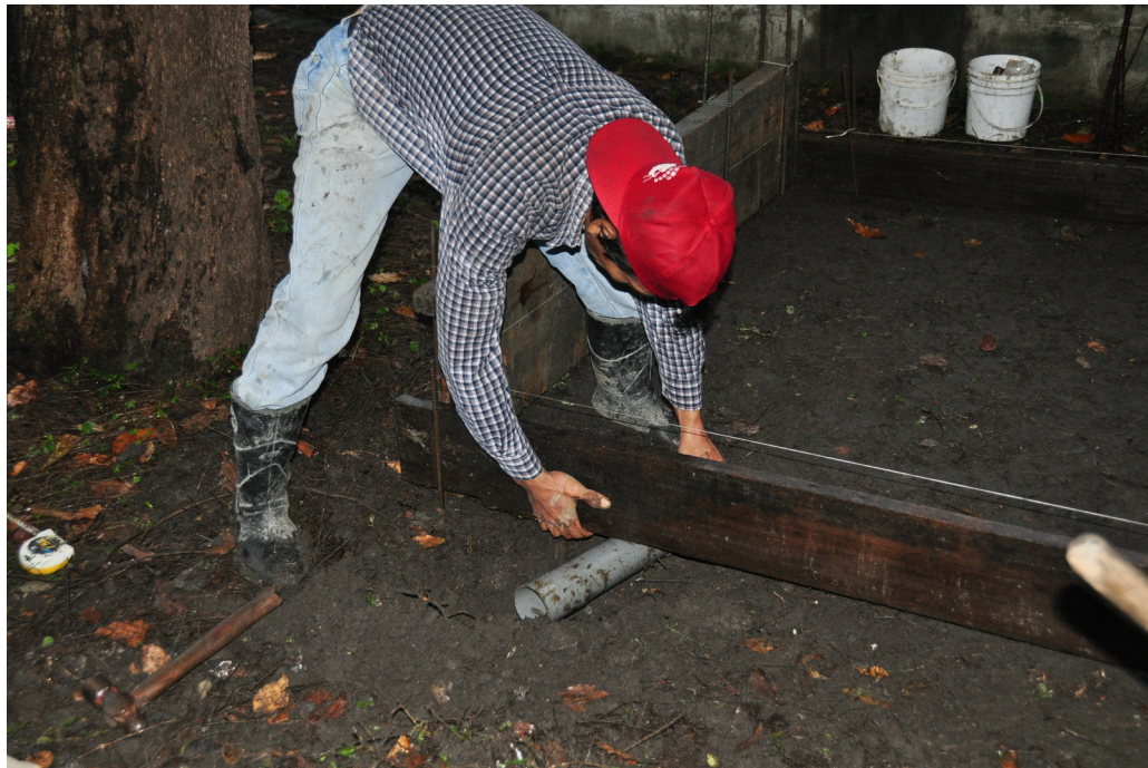
水泥磚造堆肥區工程施作(照片一)
