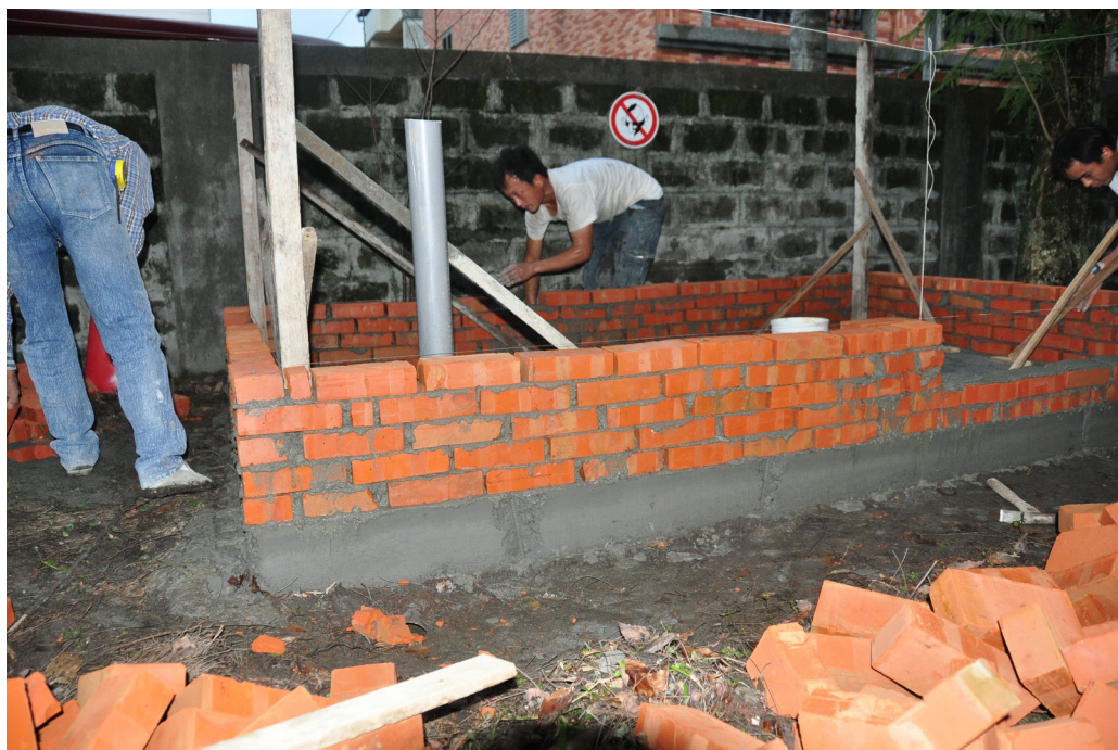
水泥磚造堆肥區工程施作(照片二)
