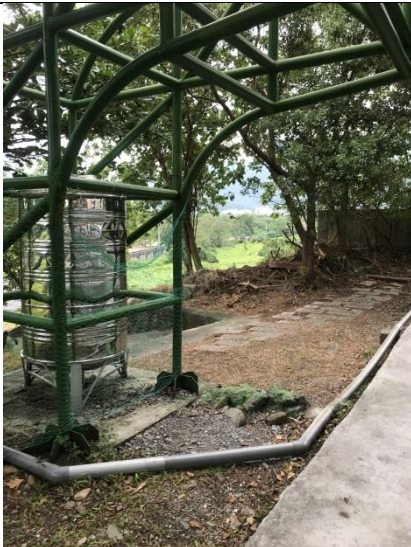
設置雨撲滿收集雨水再利用
