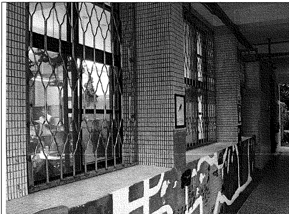
拆除鐵窗裝設外推式窗戶，有足夠的窗台不會影響行的安全。
