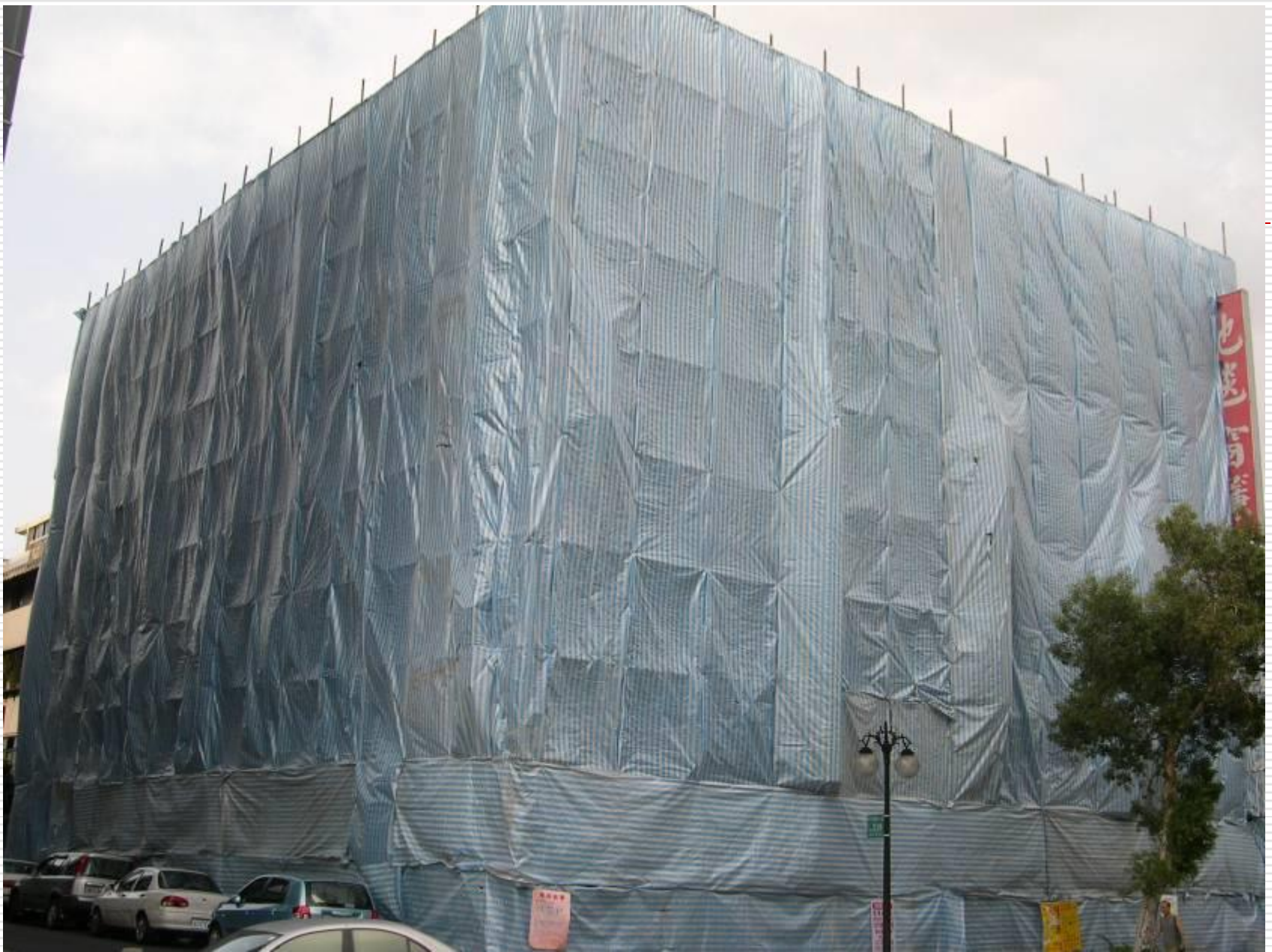
建築工地減少污染的方法
