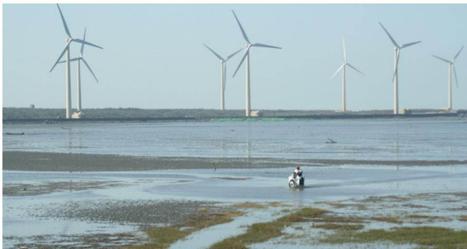
這是高高聳立在台中海濱的風力發電裝置。海風一吹，風扇轉動，轉軸上帶著磁鐵一起轉，磁鐵周圍有大網大網的線圈，電就來啦！這是我們的轉轉發電的放大版。
