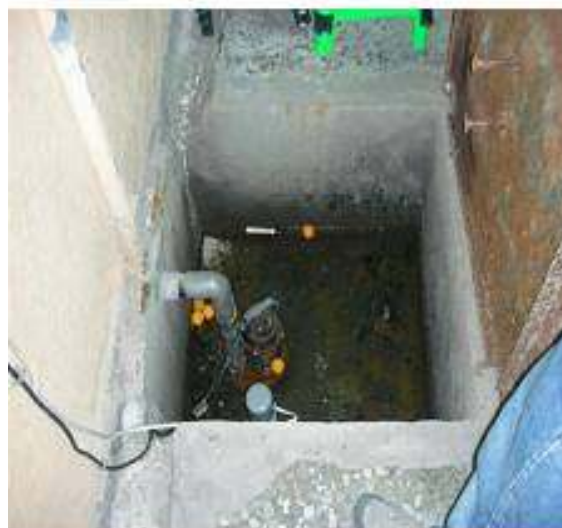
地下室集水槽
