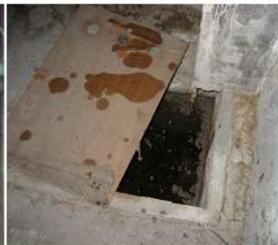
地下室污水池
