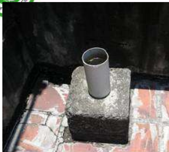
水泥樁上之水管
