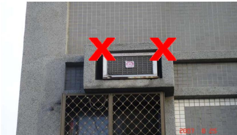
圖九 原本設計避免冷氣機日晒雨淋
