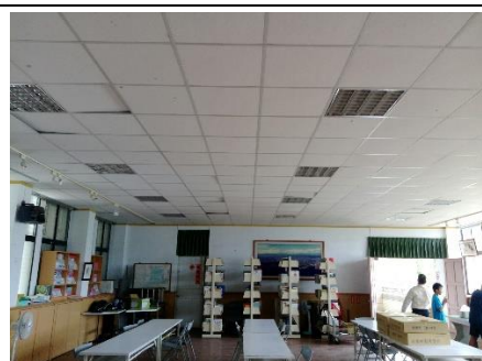
綜合教室施工前
