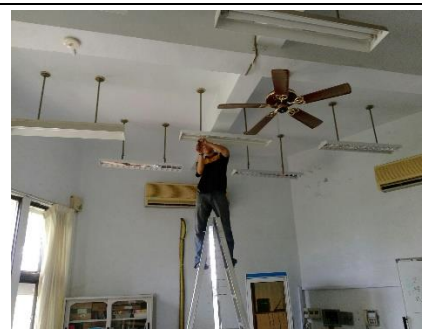
電腦教室施工中
