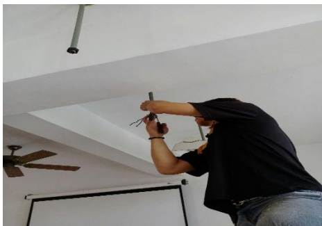
圖書室施工中
