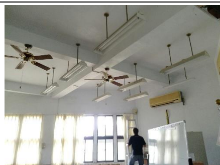
電腦教室施工前
