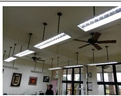
校長室施工後
