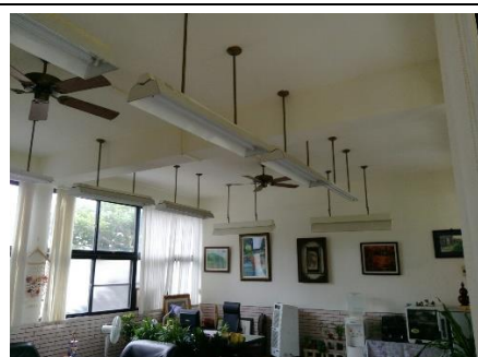
校長室施工前
