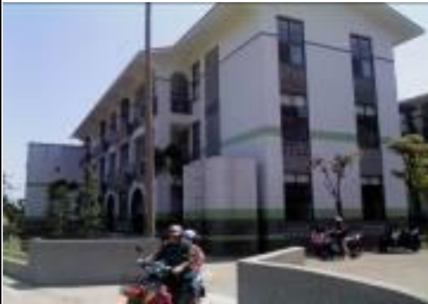
汽機車停車場
