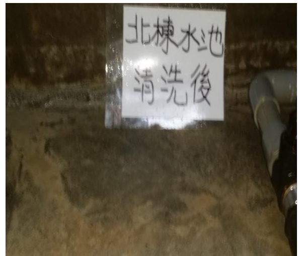
說明：北棟水池清洗後
