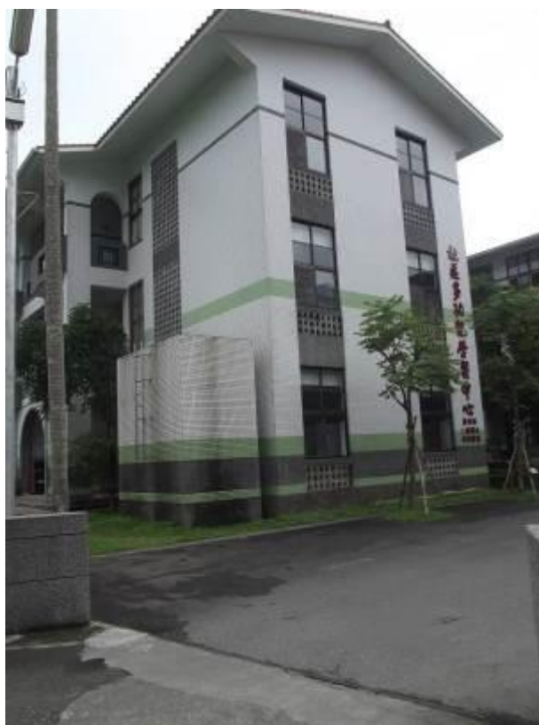
社區多功能學習中心---北側門出入口
