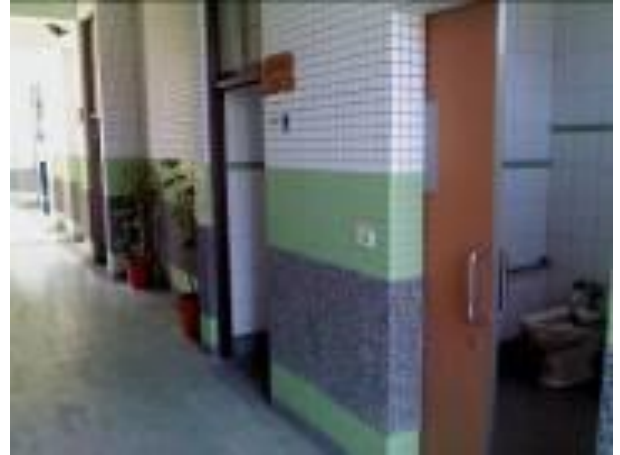
男廁、女廁及殘障廁所各乙間
