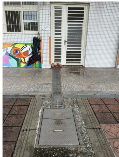
廚房污水妥善處理
