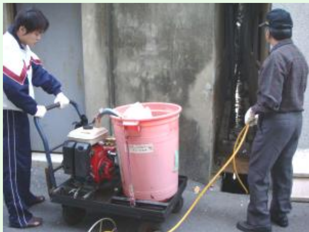
清理防火巷污水溝的高壓噴管
