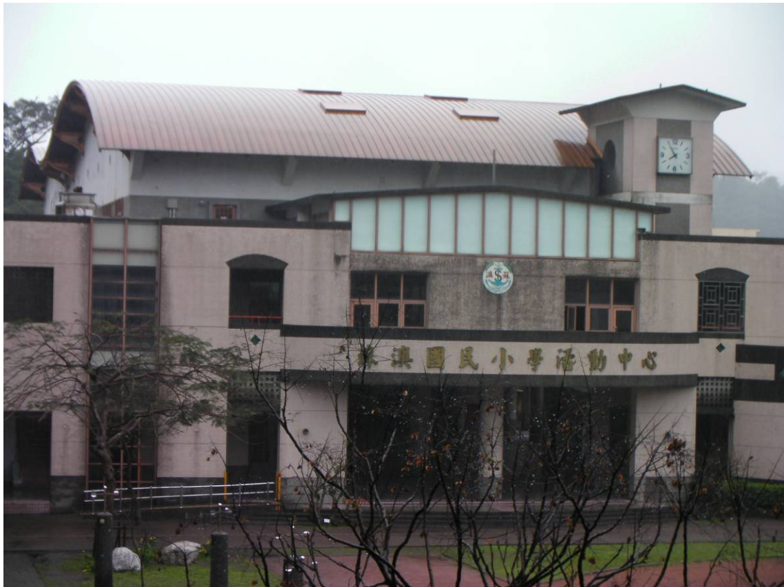
活動中心屋頂外觀-弧形鍍鋅鋼浪板
