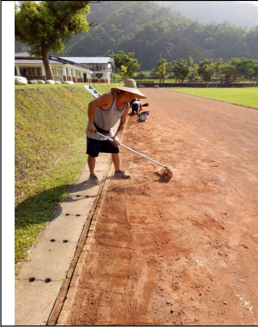
施工中說明：填補洞口
