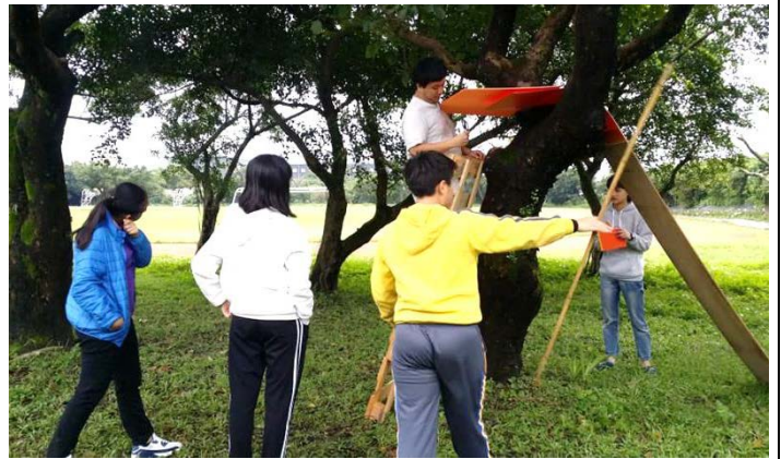
在樹上搭建臨時骨架，試驗施工實際高度
