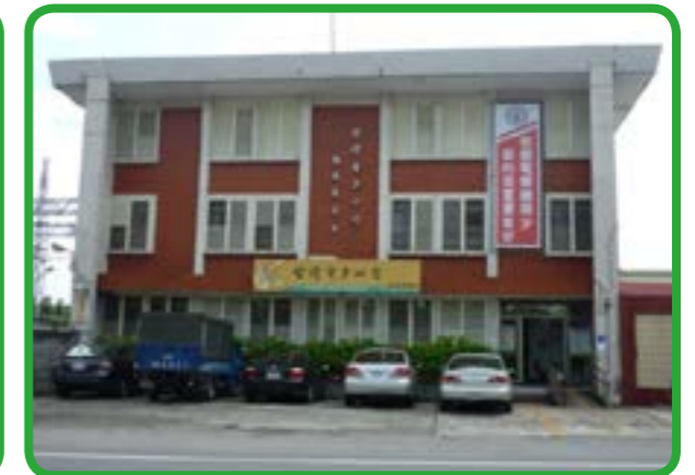
圖 4-9 臺灣電力公司頭城服務所
