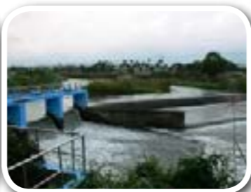
安農溪 流域有 相 當多的灌溉設施
