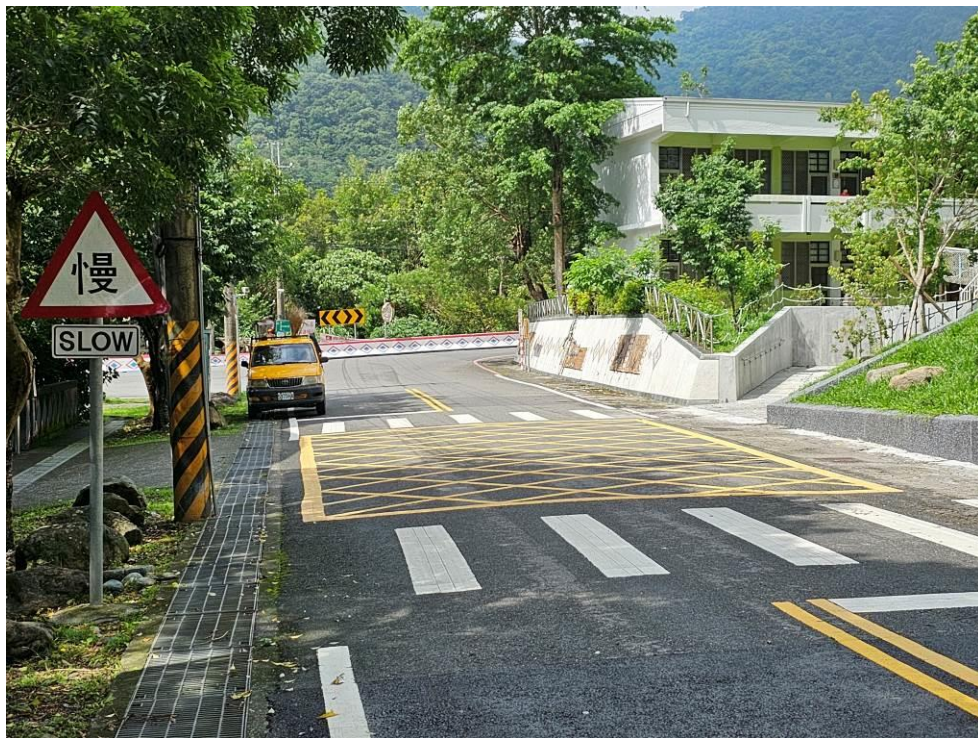
說明：家長接送區出口處設置車輛慢行標誌，維護家長和師生上放學安全
