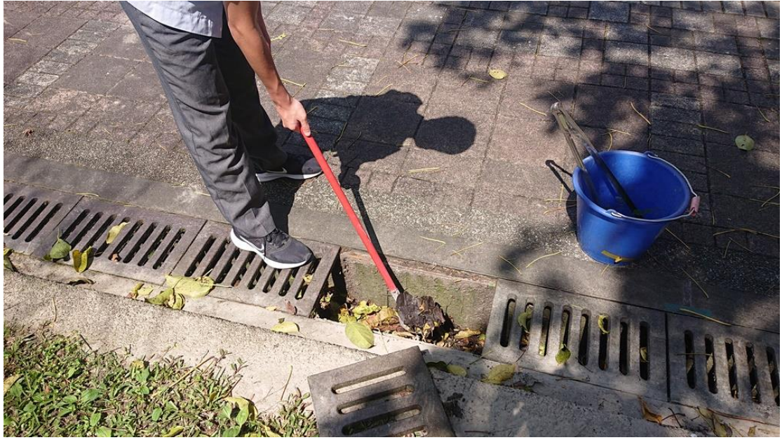
清水溝:挖出汙泥
