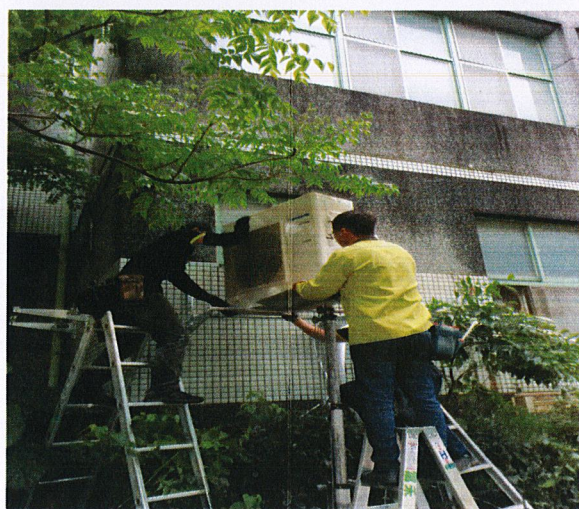
※無風管空調機提供裝設中照片
