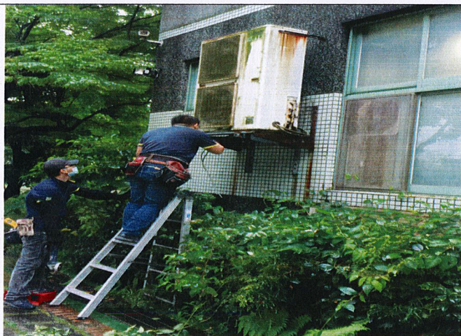
※無風管空調機提供拆除中照片
