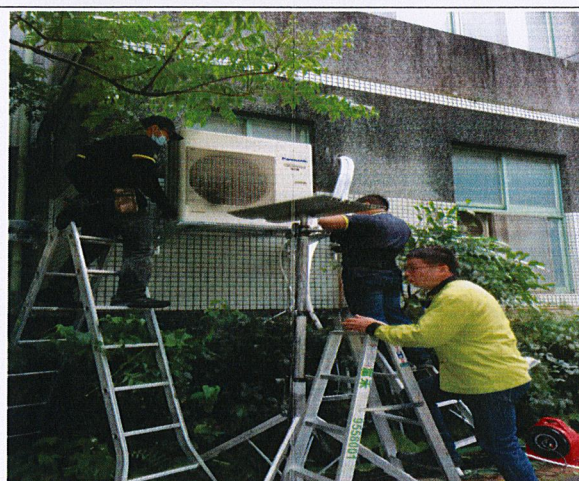
無風管空調機提供裝設中照片
