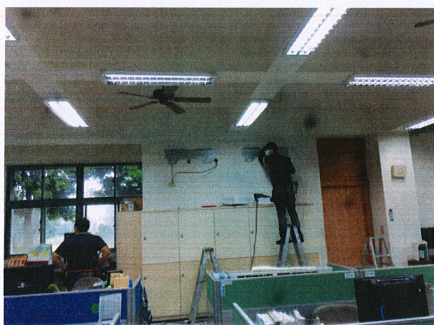
※無風管空調機提供裝設中照片
