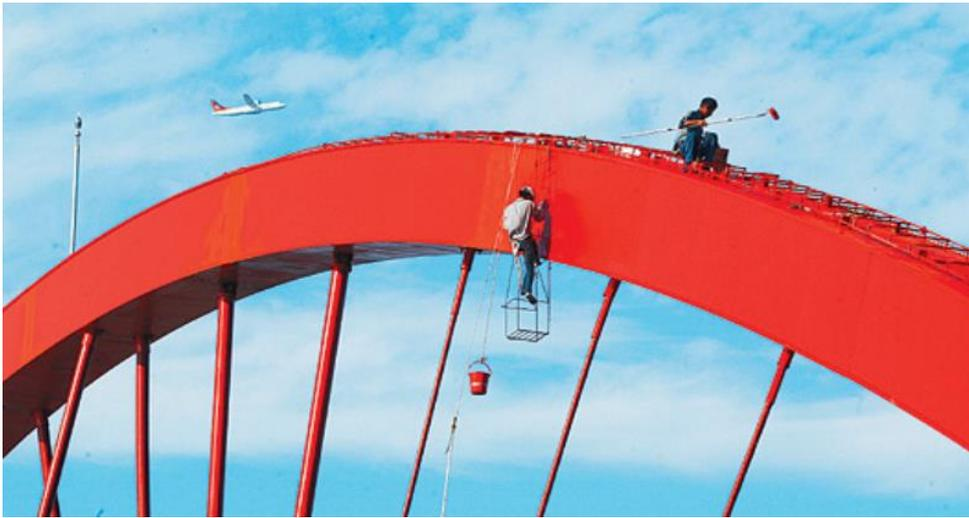
鋼構橋梁易遭酸雨、日曬、海水鹽分和車輛震動破壞。傳統上，人們會在橋的表面塗上抗鏽漆；更先進的做法，則是鍍上一層鋅來避免氧化。圖／本報資料照片
